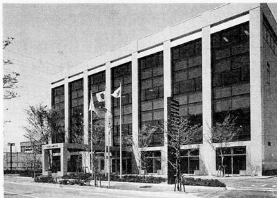
太田商工会議所会館の全景
